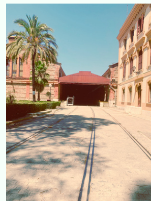
El Ayuntamiento de Cádiz ha mantenido un encuentro con Agentes Sociales de la ciudad para mostrar el proyecto de reforma y visitar las instalaciones de los antiguos Depósitos de Tabaco.
